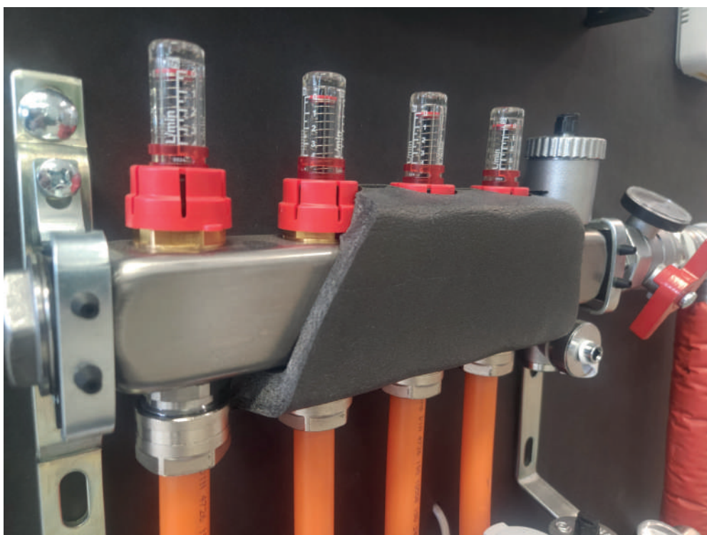
Isolatie van de RVS verdeler
