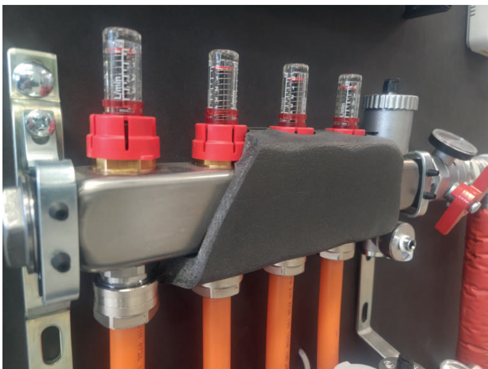
Isolatie van de RVS verdeler
